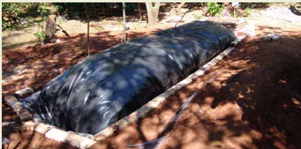
Figura 9: BIODIGESTOR INSTALADO EN UNA DE LAS 20 FINCAS FAMILIARES BENEFICIADAS
